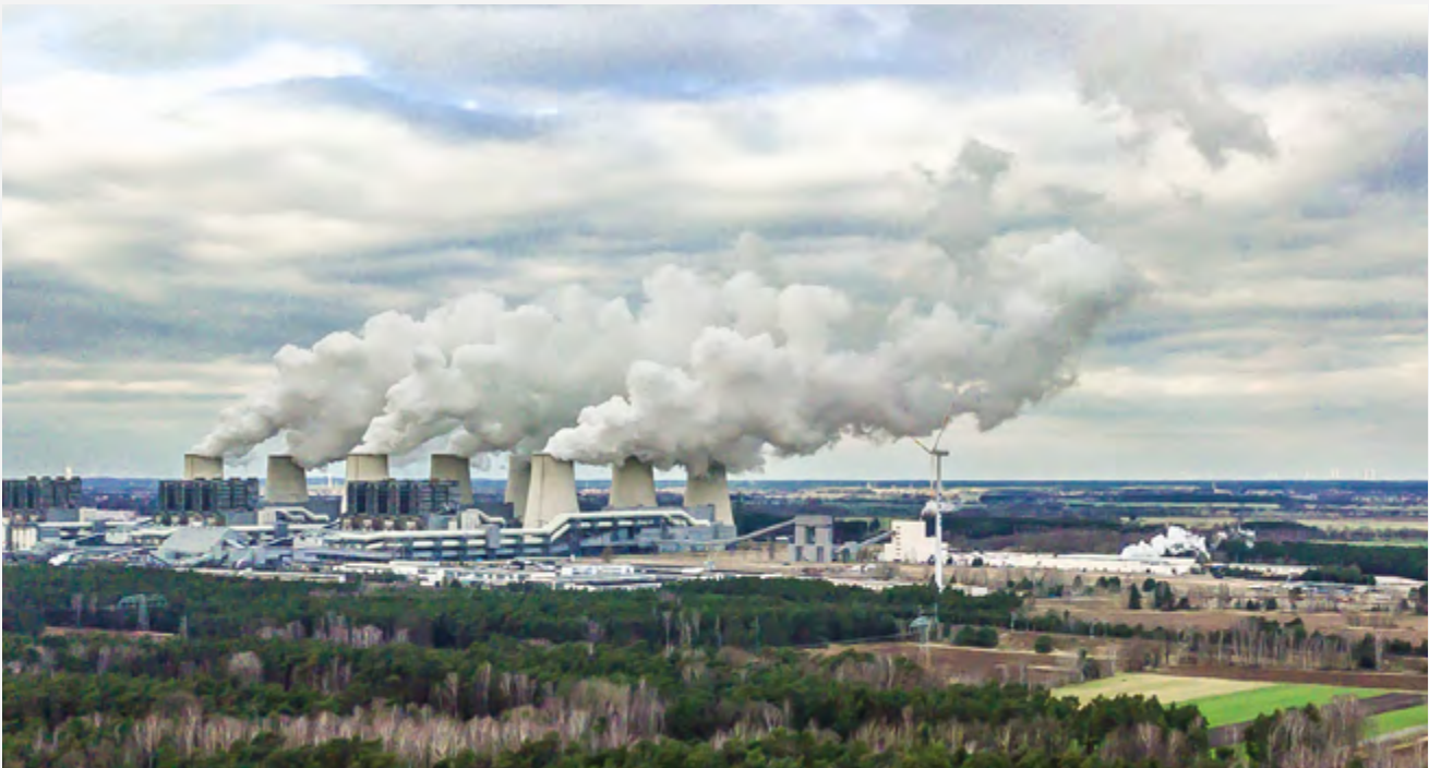
Braunkohlekraftwerk Jämschwalde © www.ideengruen.de | markus pichlmaier
